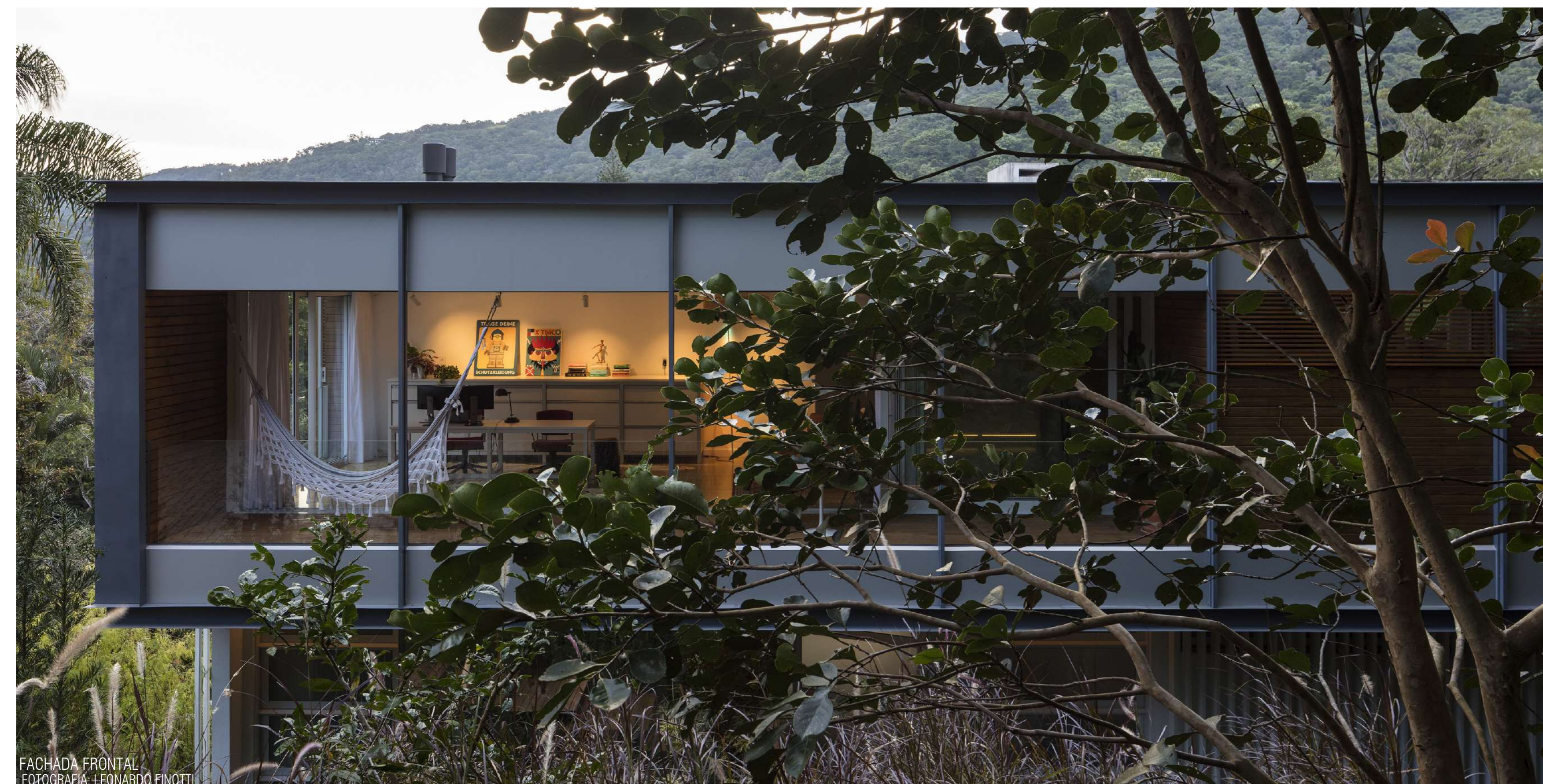
FACHADA POSTERIOR FOTOGRAFIA: LEONARDO FINOTTI
